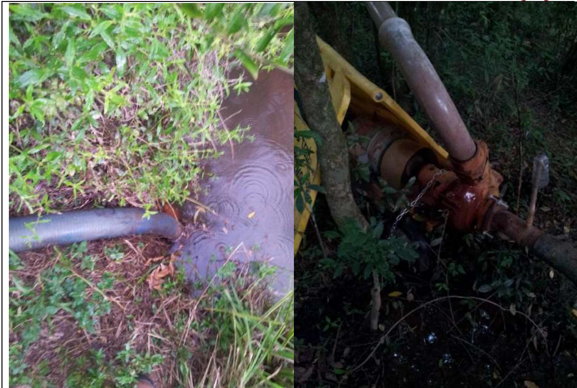
Figura 30 - Captação emergencial no Córrego Cachoeirinha Fonte: SAMENCO, 2014.
