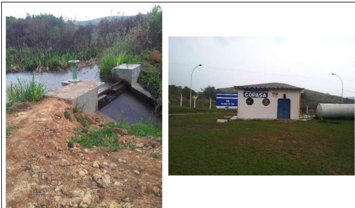
Figura 45 - Captação no Córrego do Vau Fonte: SAMENCO, 2014
