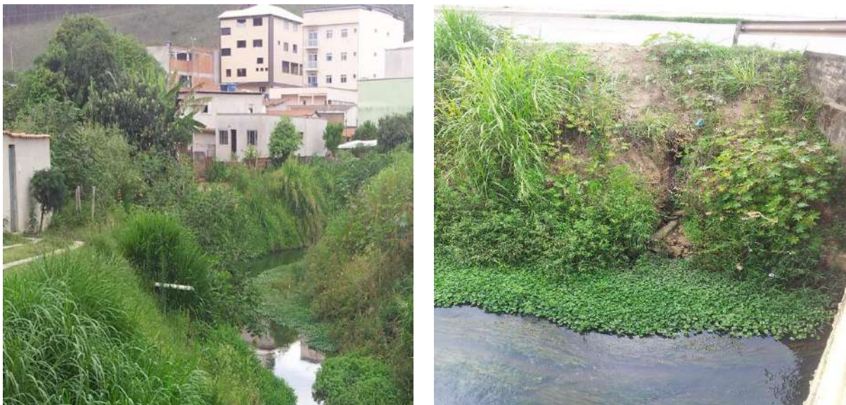
Figura 57 - Lançamento de esgoto em curso d'água Fonte: SAMENCO, 2014.
