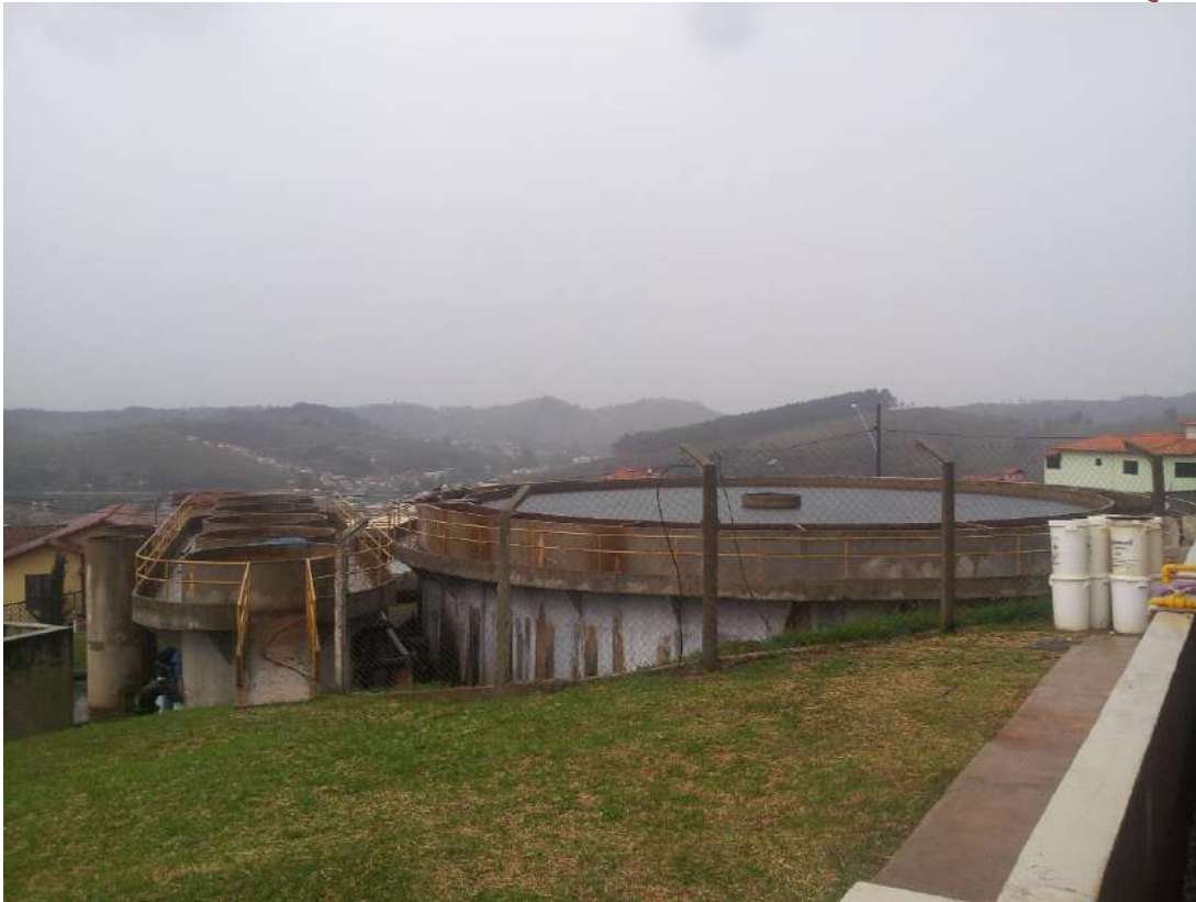
Figura 29 - Nova ETA Carandaí – Capacidade de 60l/s, ainda inoperante Fonte: SAMENCO, 2014.
