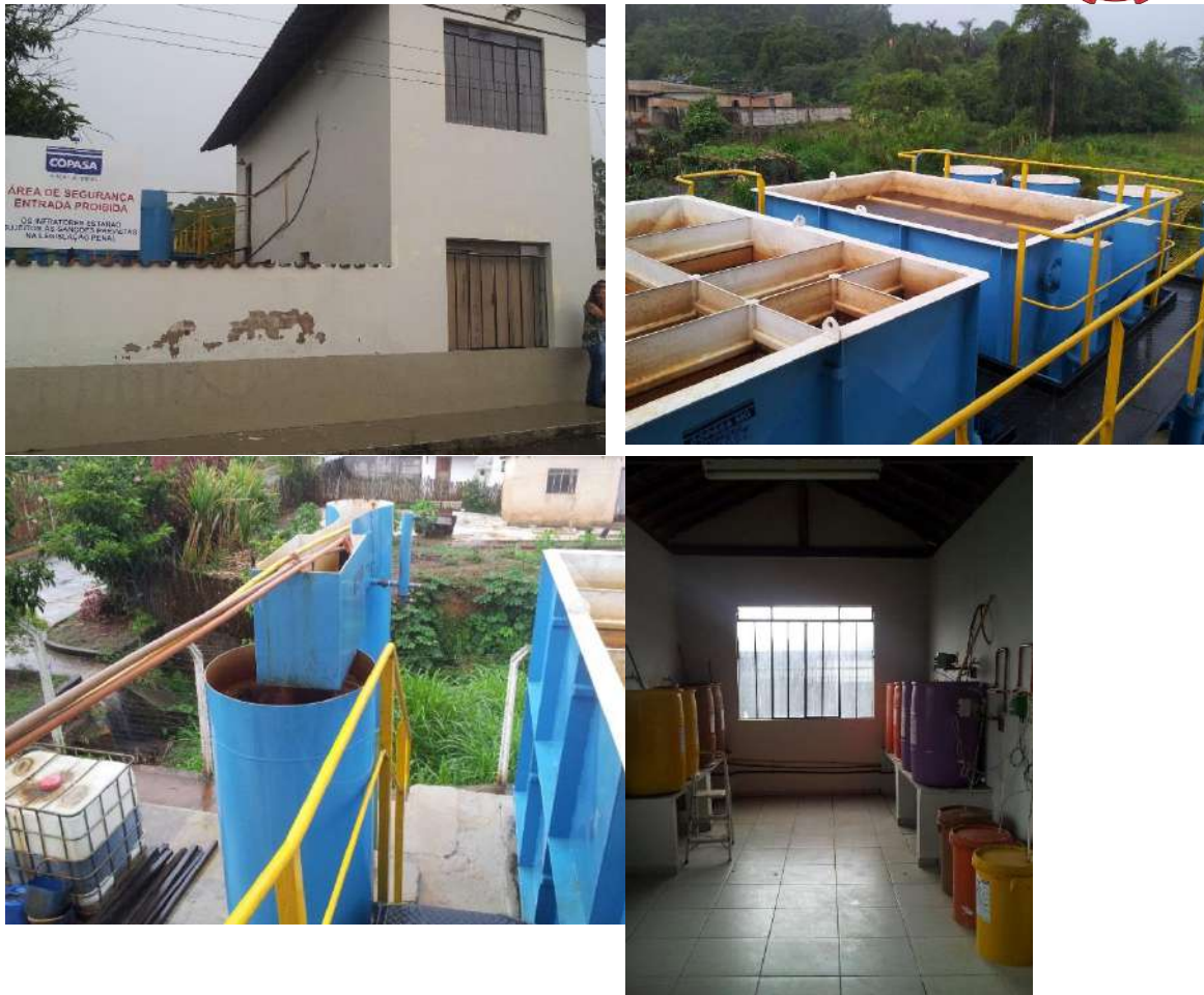
Figura 52 - ETA Pedra do Sino Fonte: COPASA, 2014.
