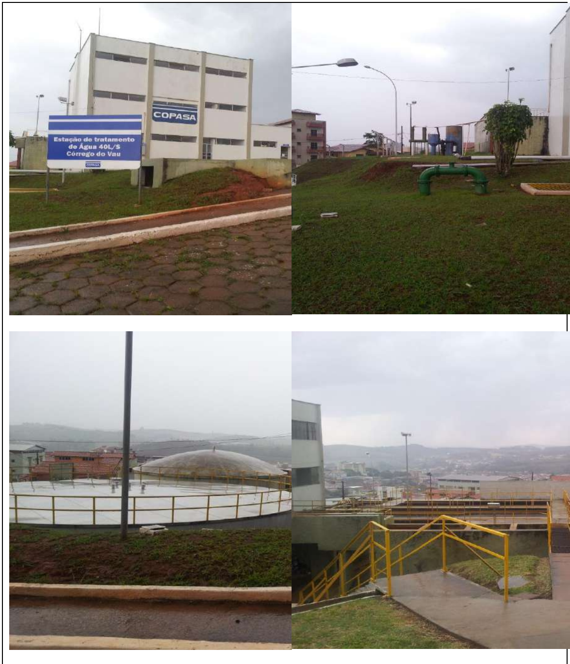
Figura 25 - ETA Carandaí Fonte: SAMENCO, 2014.
