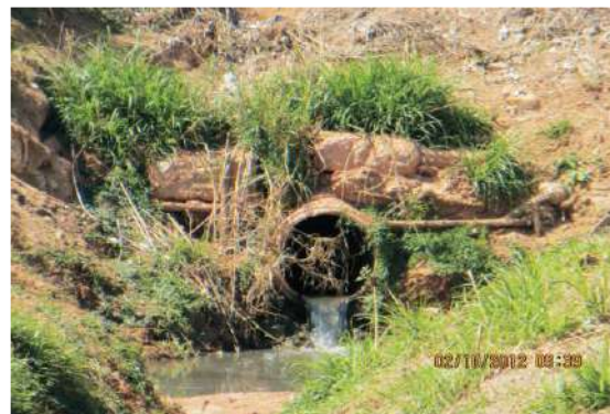
Figura 50 - Estrangulamento do Capão do Melo provocando refluxo das águas no Centro Fonte: CPRM, 2012.
