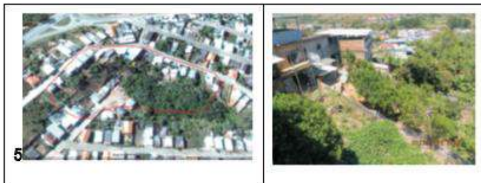
Figura 74 - Áreas suscetíveis à erosão em Carandaí Fonte: CPRM/2012
